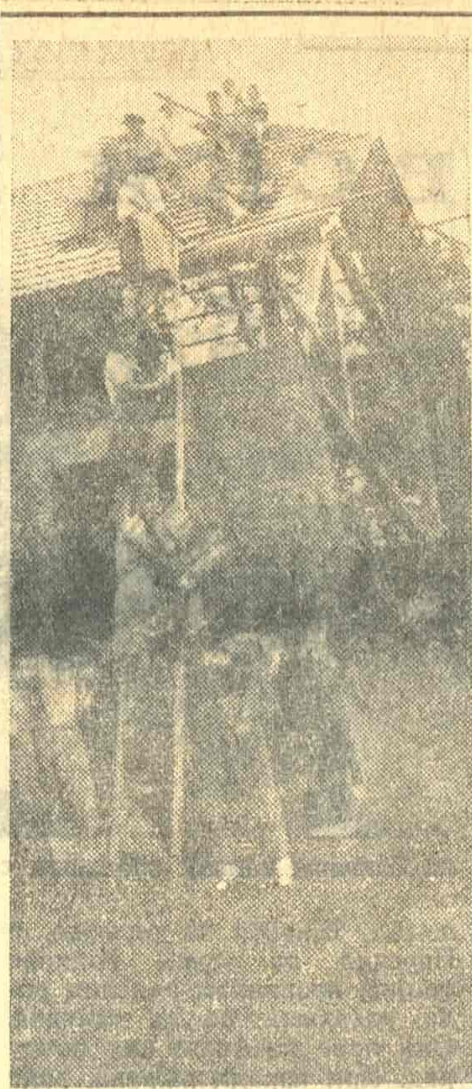
Изградња нових домова
