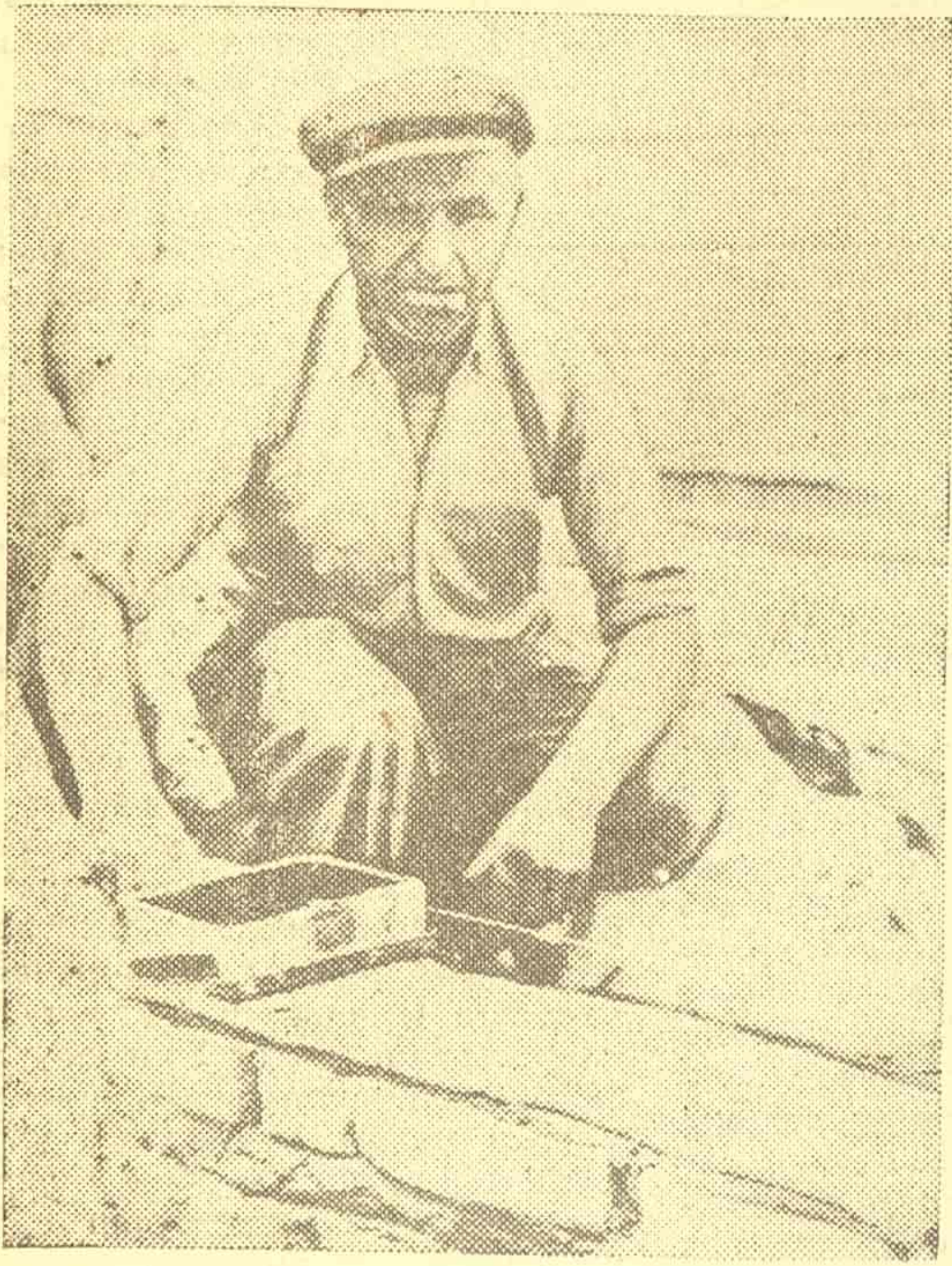
Глигор Тодоровић је својим справом за распрострањање малтера знатно убрзао рад на својим градилиштима. Уместо послања зида малтером и употребе мистрије калупом који је конструисао Тодоровић равномерно се распростире малтер по целој ширини зида.
