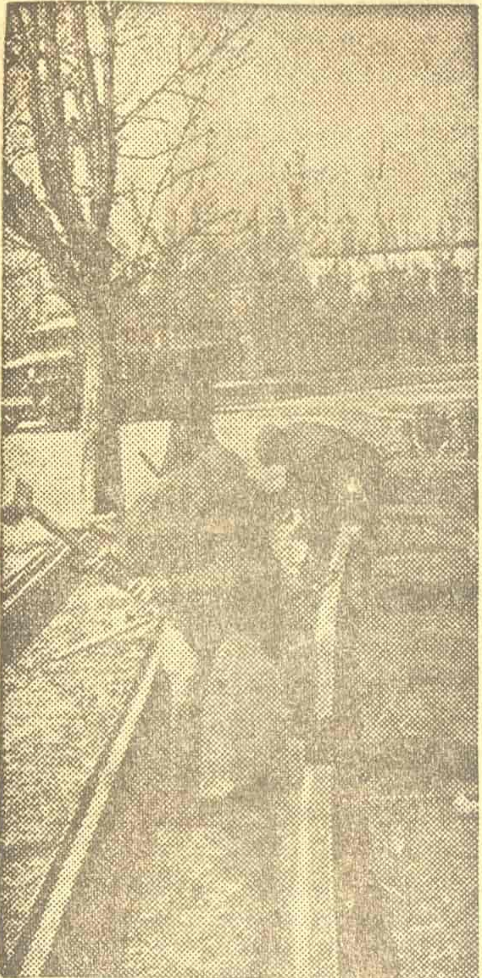
Да би се уредно коловоз на простору Топчидерског брда, а и да би се користиле на другом месту, ваде се остајици шина некадашње „дванаестице“
