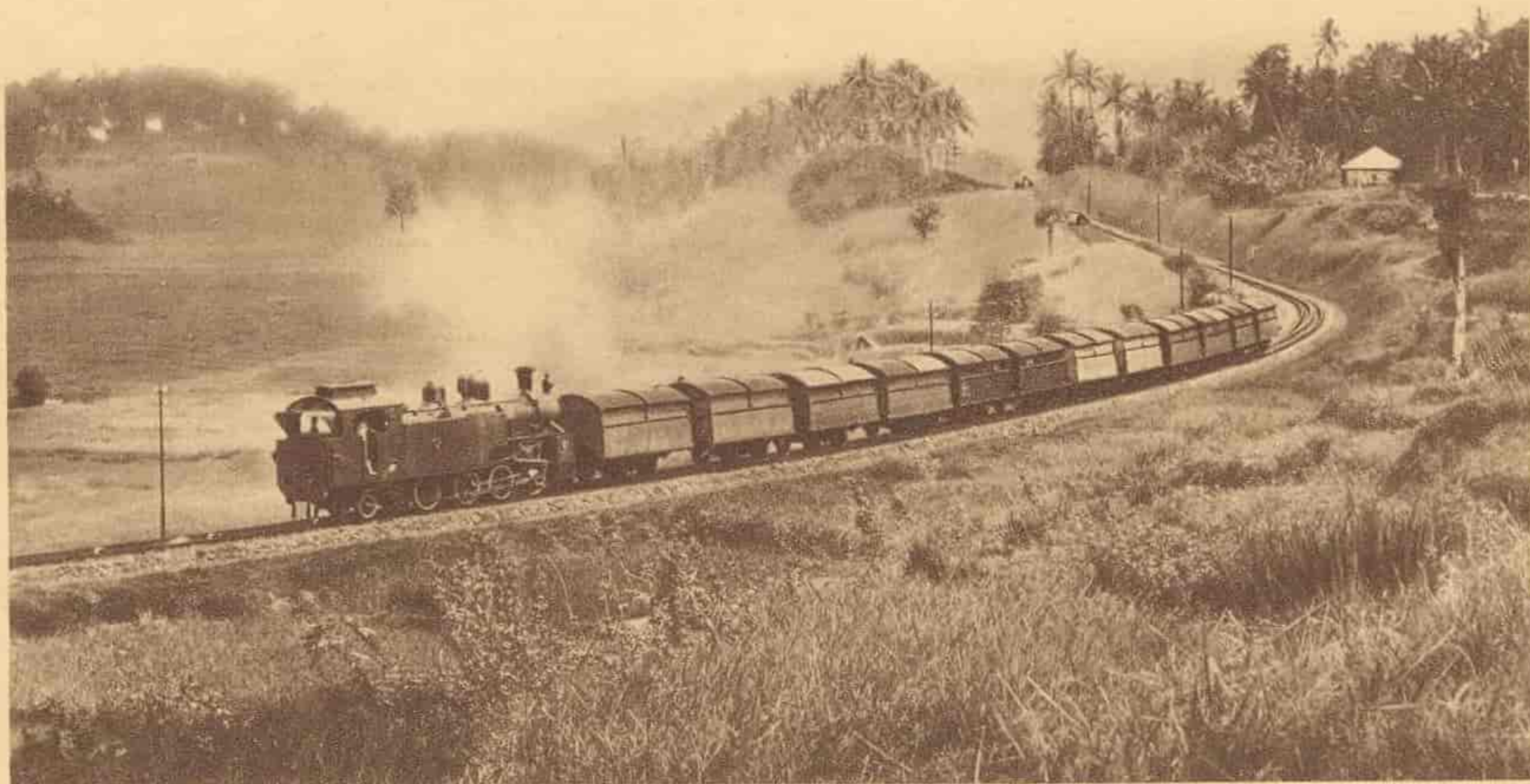
Trein dari 180 ton jang memoeat arang-batoe, didorong dengan tandradlocomotief O D 1, didekat Batoe Tabal (Sumatra's Westkust).
