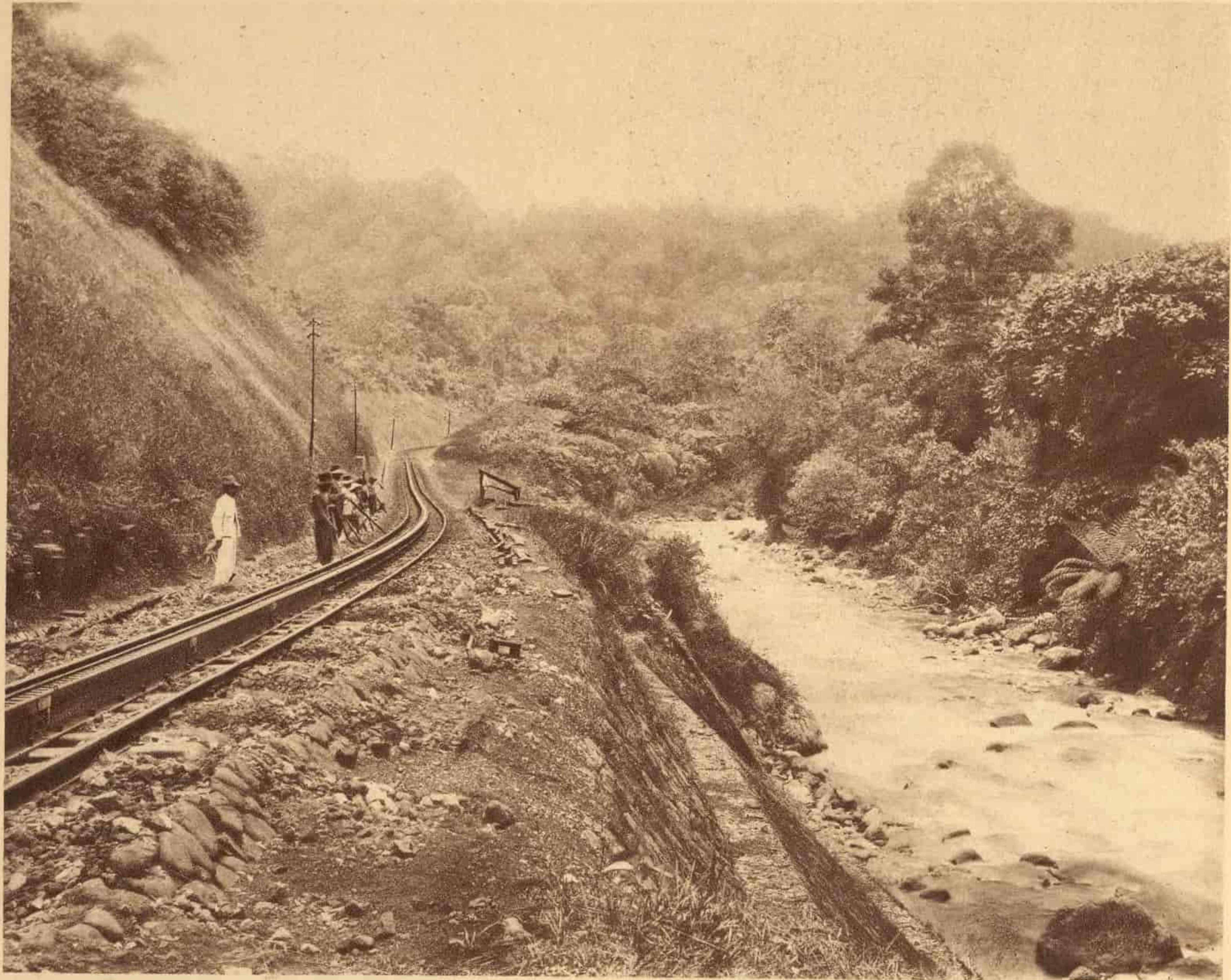
Djalan kereta-api dengan tandstaaf di Aneikloof (Sumatra's Westkust). De spoorrails en tandstaaf route in de Aneikloof
