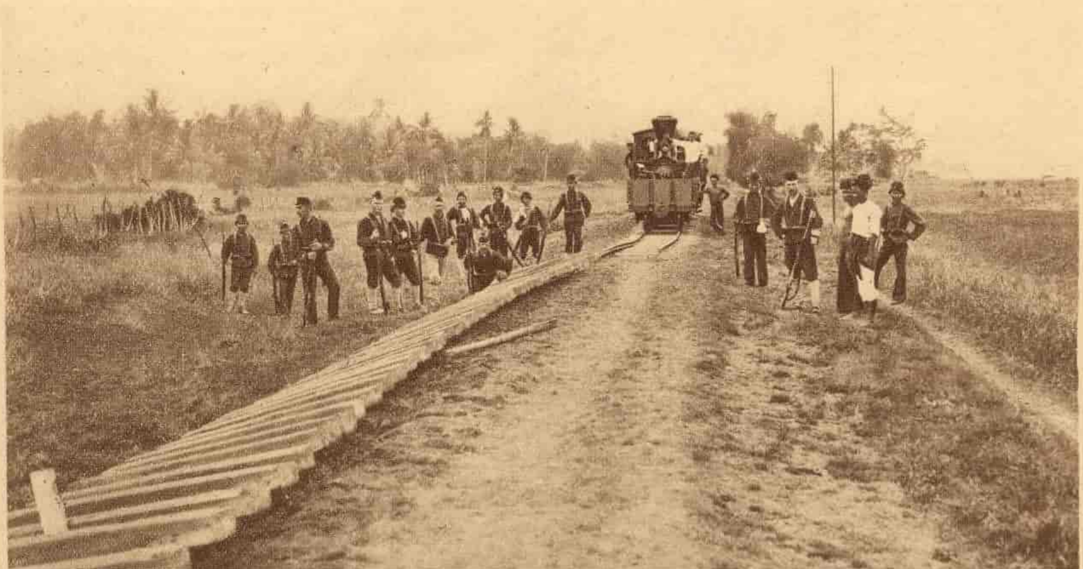
Bahagian djalan kereta-api jang dibongkar oleh moesoeh bangsa Atjeh. Een stuk van spoorrails die opgebroken door de volkeryand Atjeh
