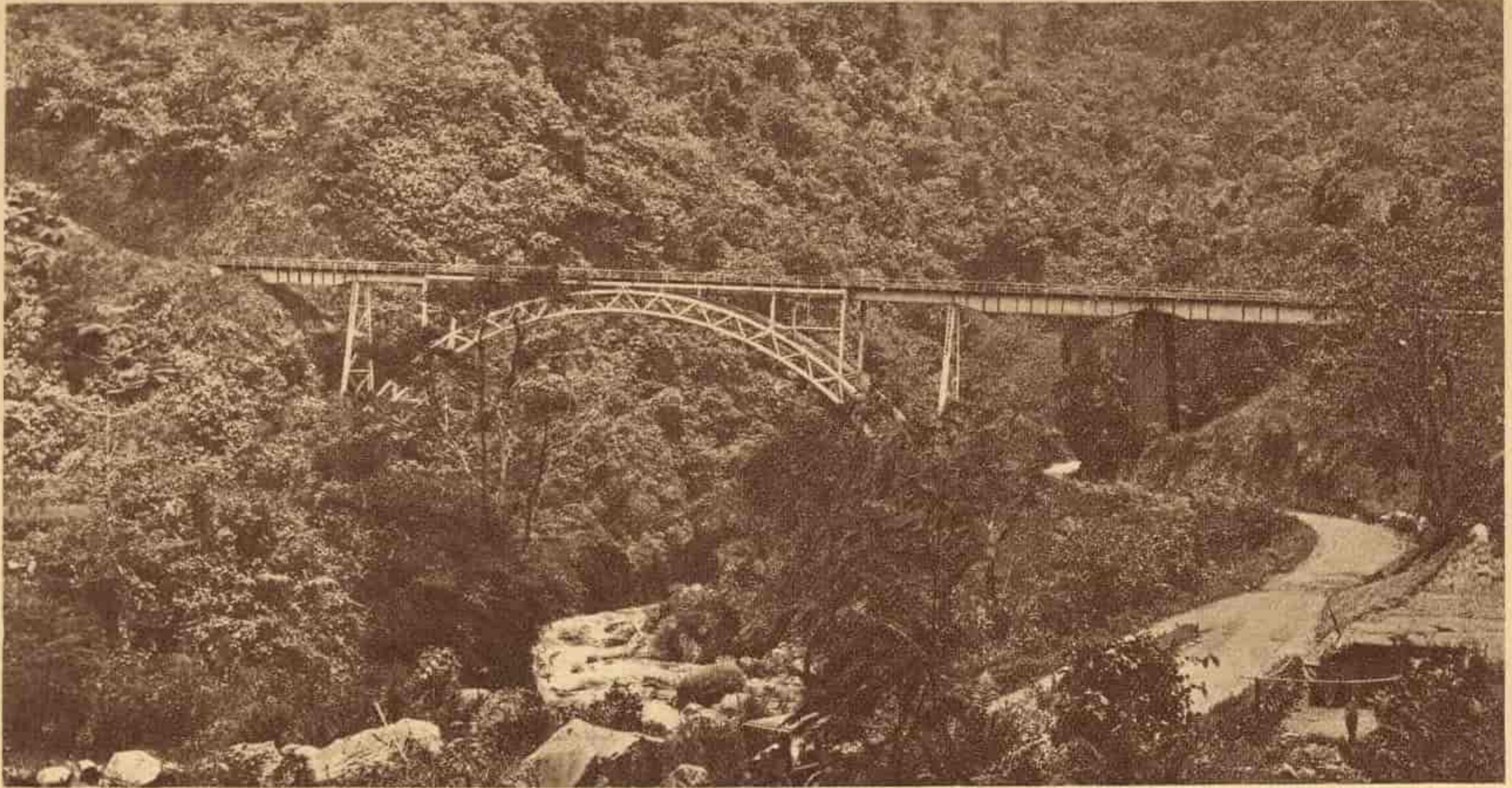
Boogbrug besar melintas soengai Anei (Sumatra's Westkust). De grote boogbrug boven de Anei rivier
