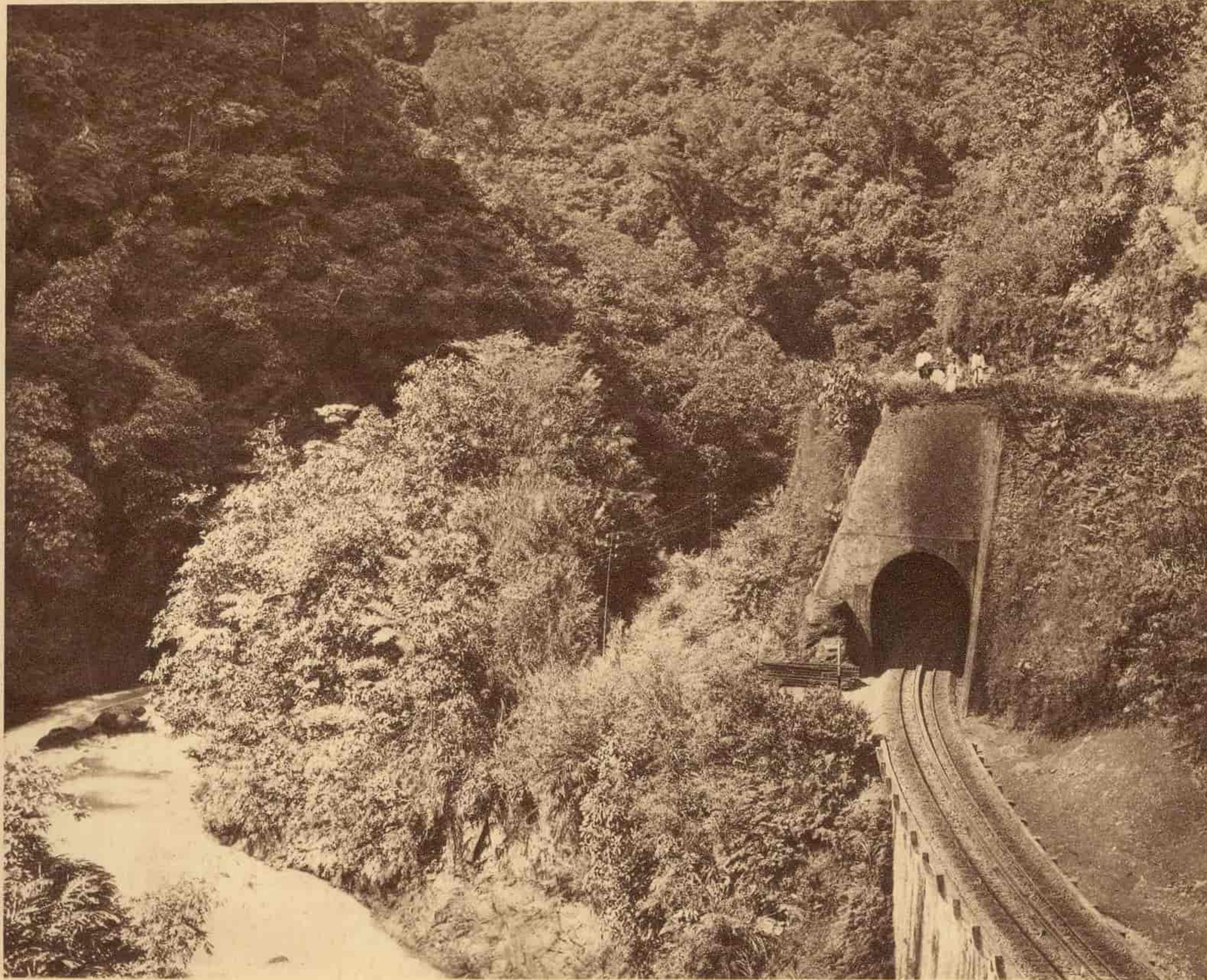
Djalanan kereta-api dengan tandstaaf diantaranja kedoea tunnel (Sumatra's Westkust). de spoorwiel met tandstaaf tussen 2 tunnels
