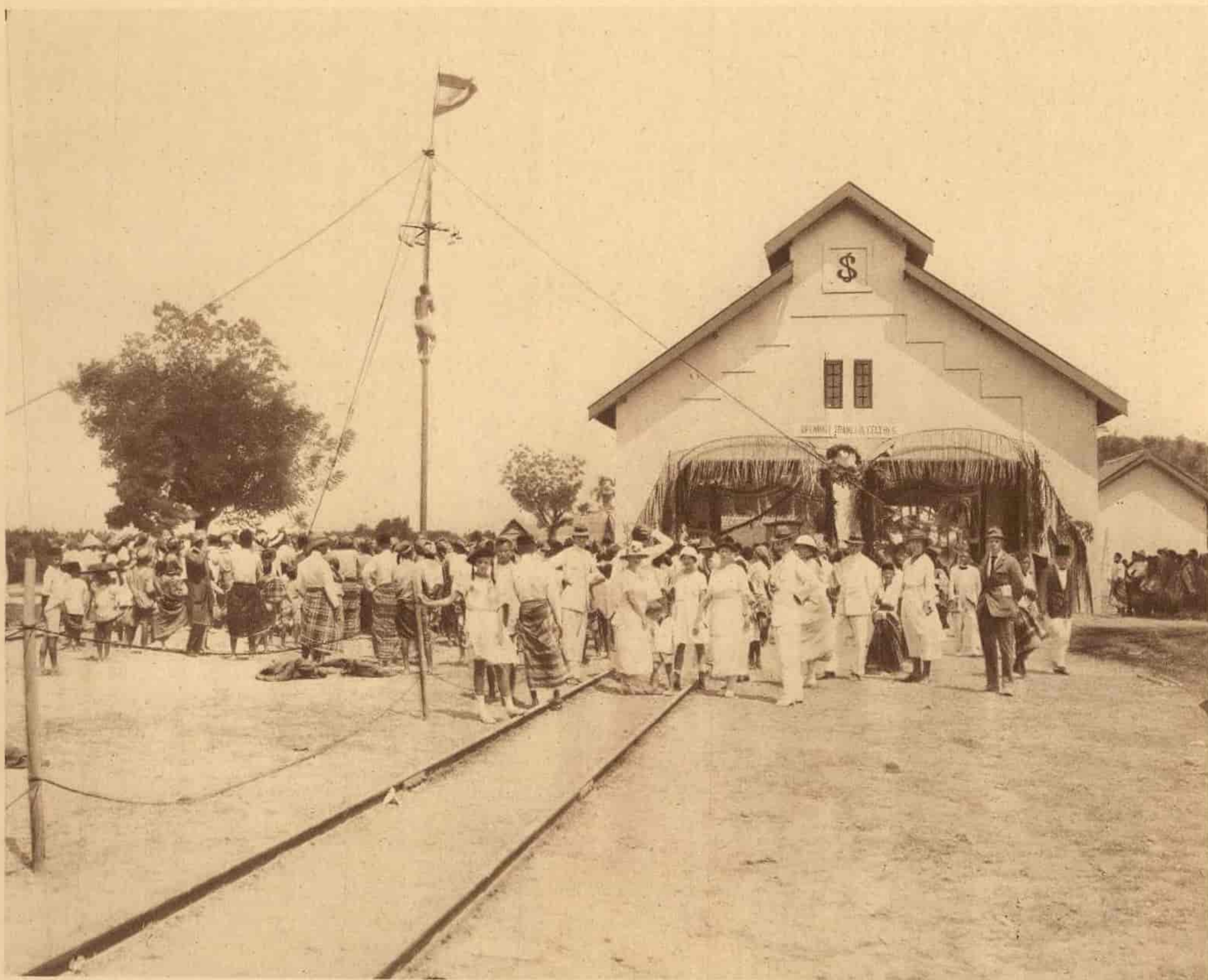
Pemboekaän djalanan tram Makassar-Takalar (Selebes). Opening van de tramweg Makassar-Takalar
