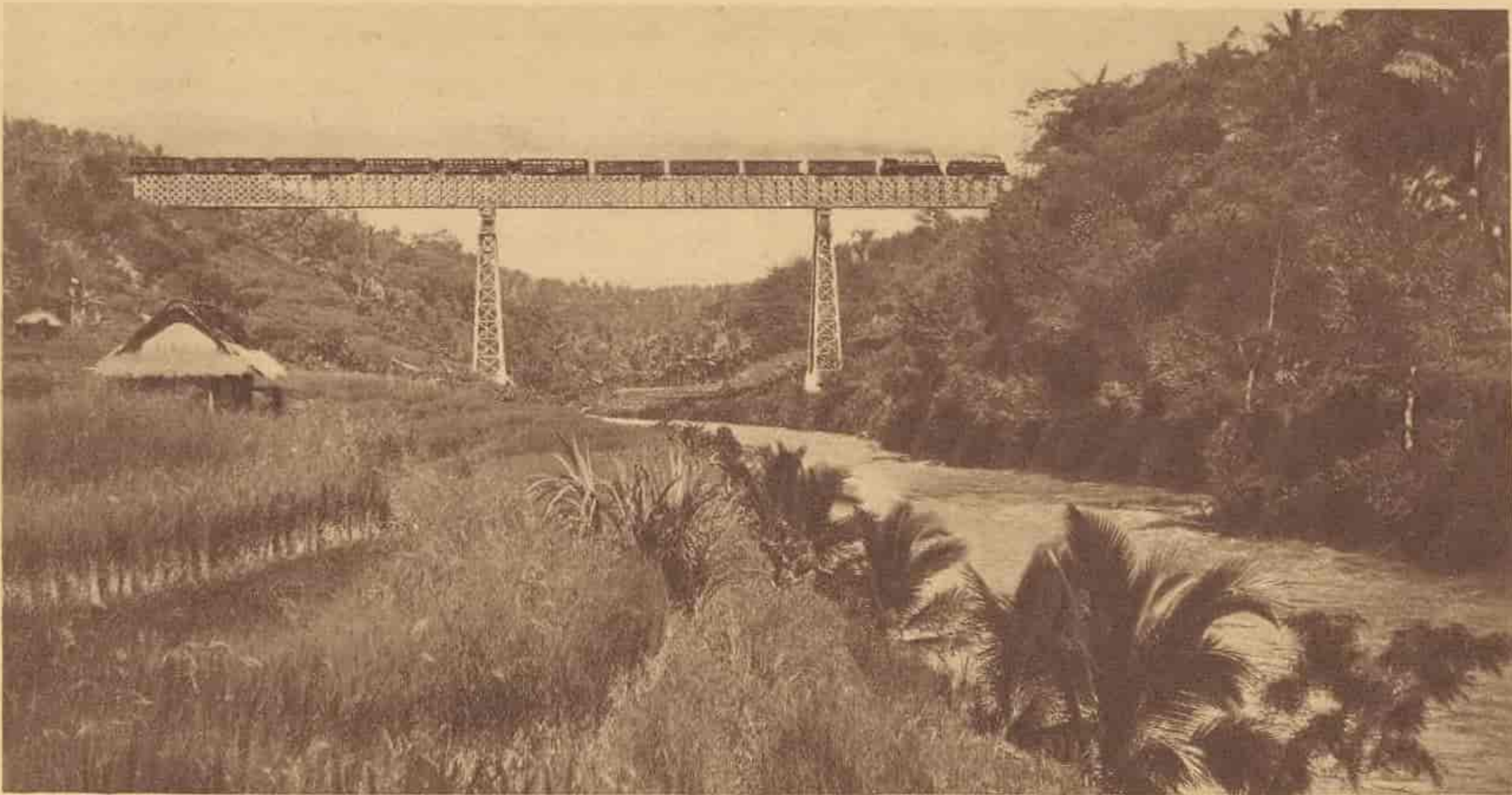
Exprestrein dengan dubbele tractie melintas djembatan didekat Tjirahong (Perdjalanan kereta-api di Priangan, dekat Tjiamis).
