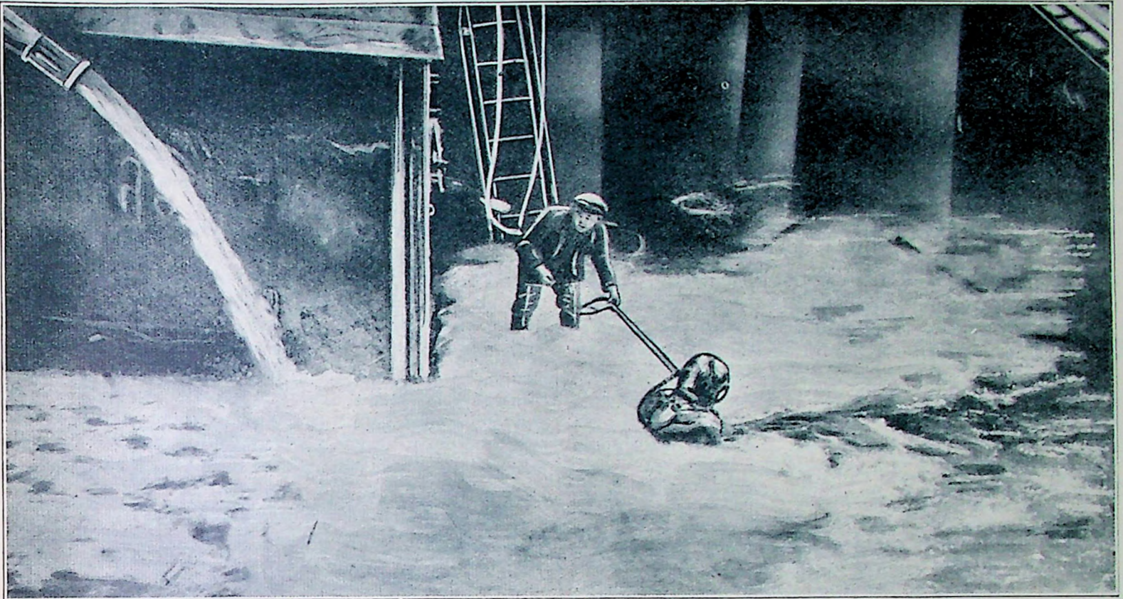
ИЗВЛАЧЕЊЕ НЕМАЧКОГ БОЈНОГ КРСТАША »ХИНДЕНБУРГ« Ронилац силази у утробу брода да зачепи пукотину (в. Листак)
