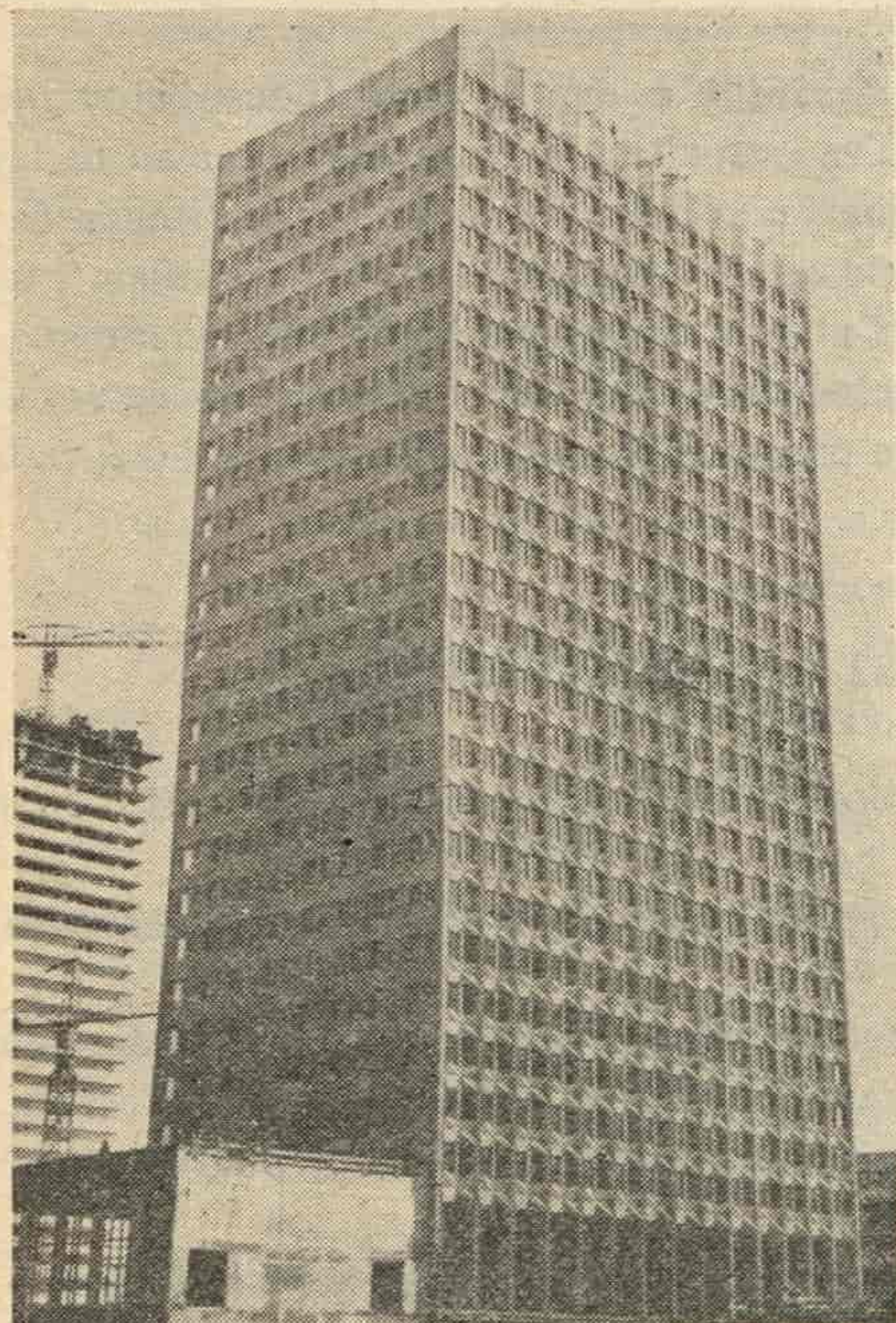
Slika 1: »Tour Europe« u izgradnji
