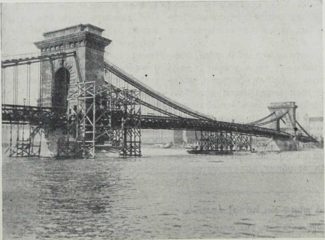
Будапешта: Оправљање Ланчаног Моста.
