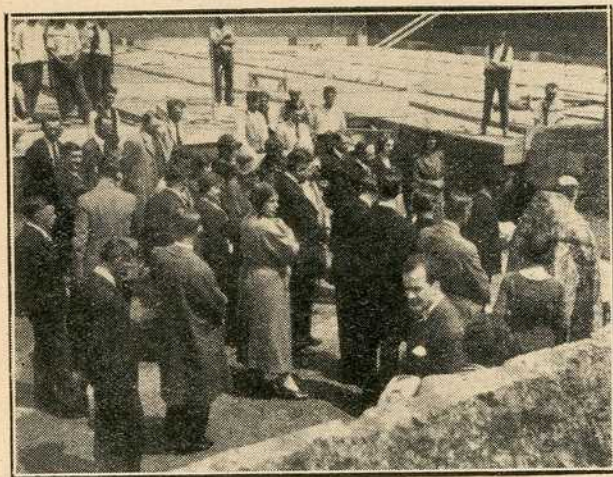
Тренутак освећења темеља новог резервоара водовода на Дедињу
