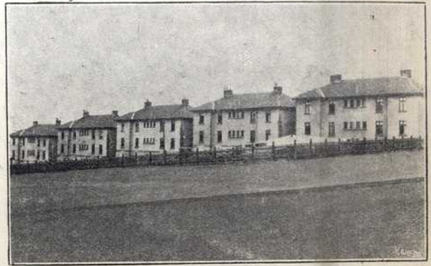
Општински станови на Топчидерском Брду (код Топовских Шупа)
