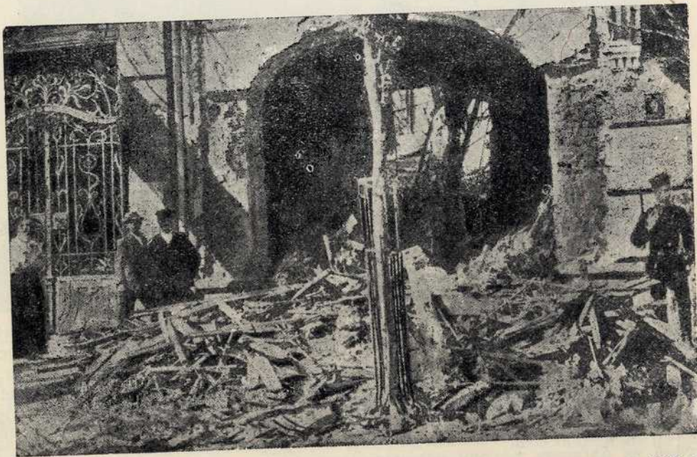
Зграда до „Колосума“ на Теразијама, порушена аустријским гранатама 1915 год.
