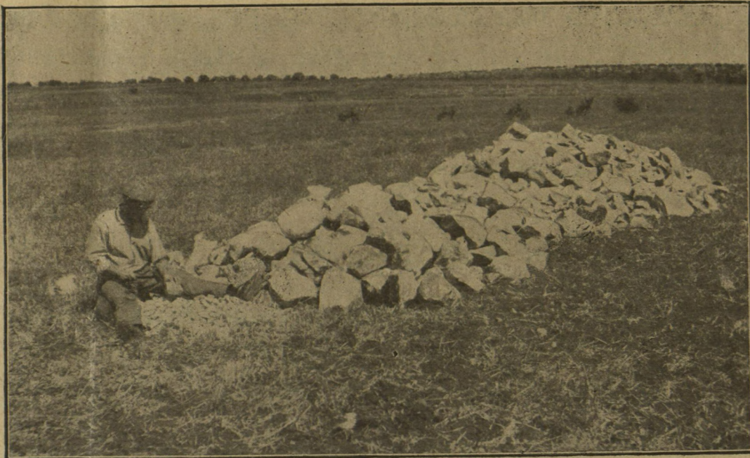
Gradnja ceste. — Haluc Jakica Baruh tuca kamen za cestu naselja.
